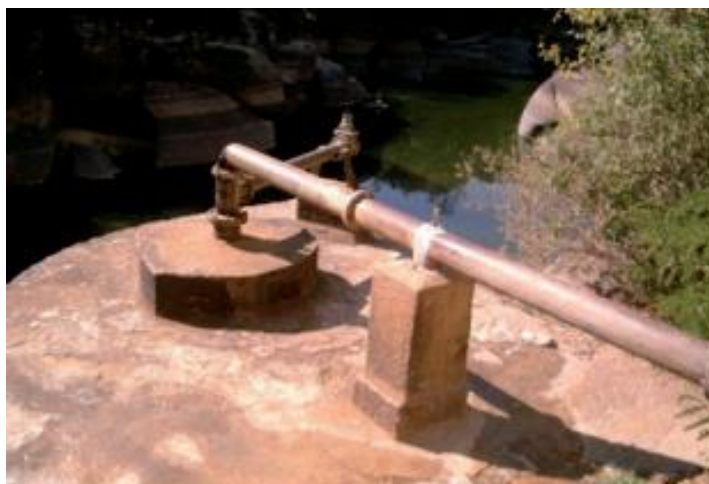
Figura 4. Captación de la surgencia de aguas bicarbonatadas sódicas del Balneario de Retortillo (Corral Lledó, et al., 2010).
