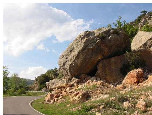
Figura 35. Aspecto de los bloques caídos cerca la carretera.
