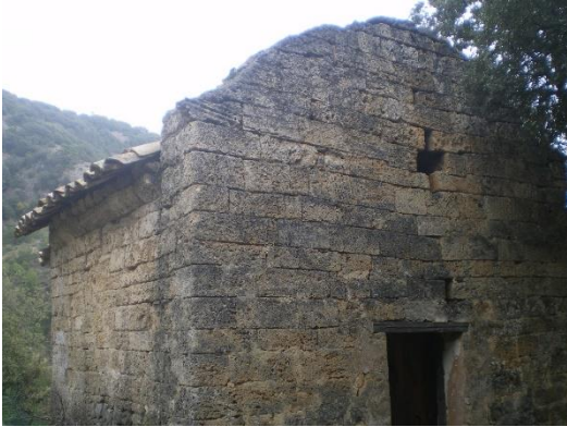
Figura 29. Ermita de Sant Quintí construïda íntegramente con tobas calcáreas formadas por la precipitación del carbonato cálcico disuelto en las aguas de la Font de Sant Quintí.
