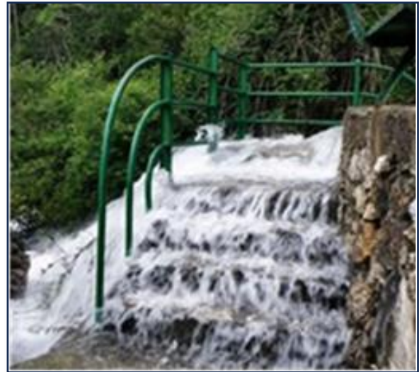
Figura 22. Época lluviosa. La surgencia inundando las escaleras de acceso.
