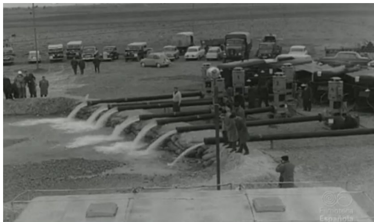
Figura 3. Aforo de la batería de 7 sondeos de El Pasico- El Salobral (Aguas Nuevas) en el año 1961 (extraído del NO-DO N 943 A).
