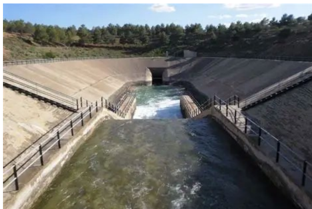
Figura 5. Inicio del túnel del Talave en el paraje de Los Anguijes, infraestructura clave del trasvase Tajo-Segura.
