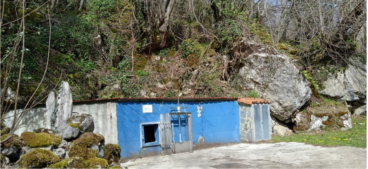
Figura 10: Caseta de captación del manantial de Fuentes Calientes. A la derecha se observan los bloques deslizados de calizas de la Fm. San Emiliano.
