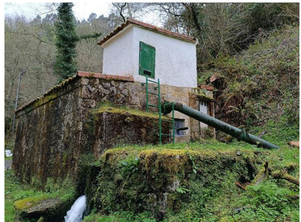
Figura 22: Estación de bombeo de agua potable (EBAP) de Obaya (Fuente: Propia)
