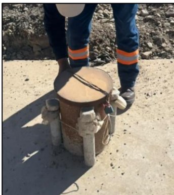
Pozo San Felipe Prolongación 1
