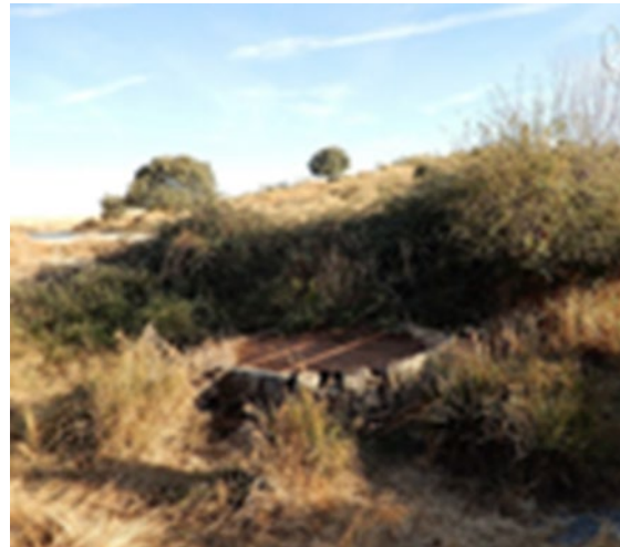
Fig. 5.- Pozo excavado en formación granular
