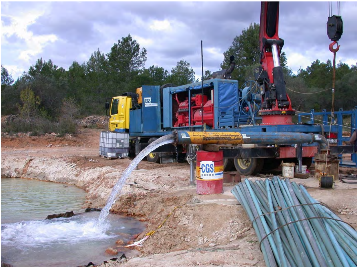
Foto 19: Ensayo de bombeo
