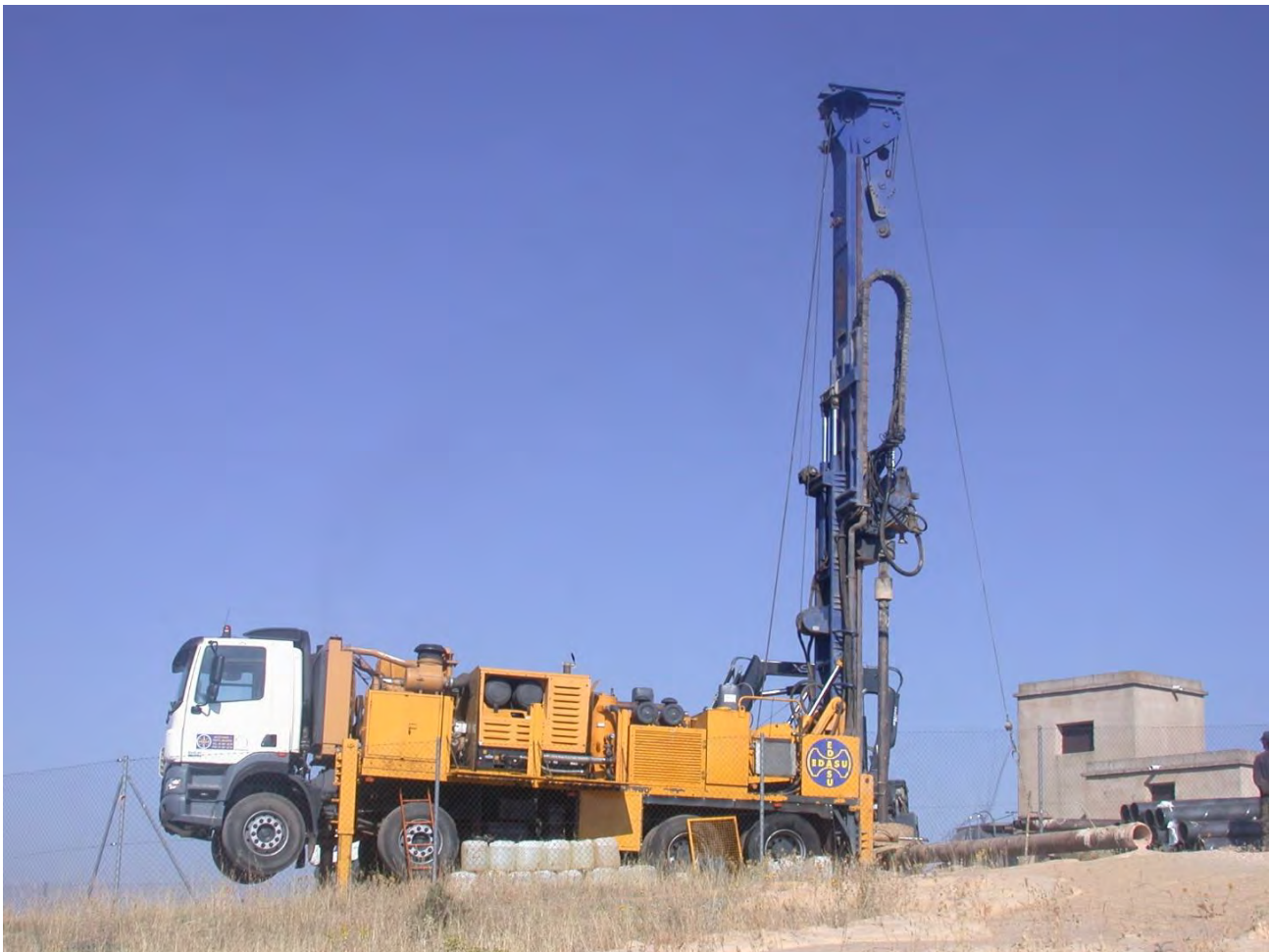
Foto 17: Perforación de un sondeo a rotopercusión
