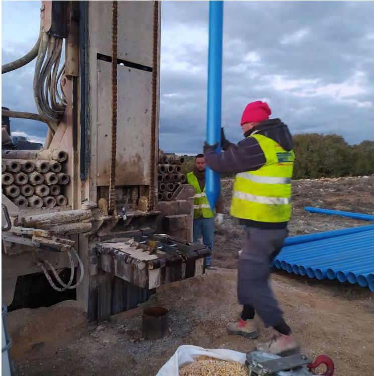
Foto 18: Entubación de un sondeo
