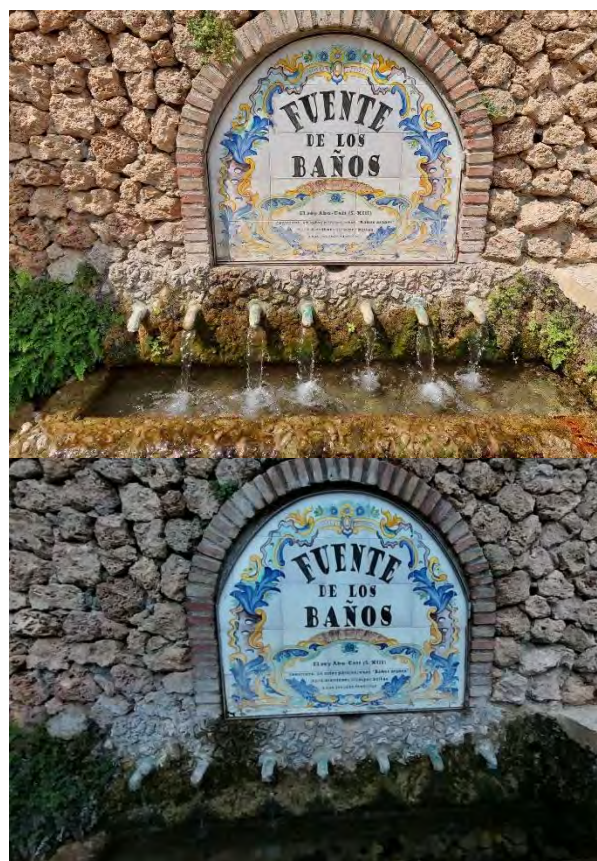
Fotos 15 y 16: Detalle de la fuente de Los Baños drenando agua y seca
