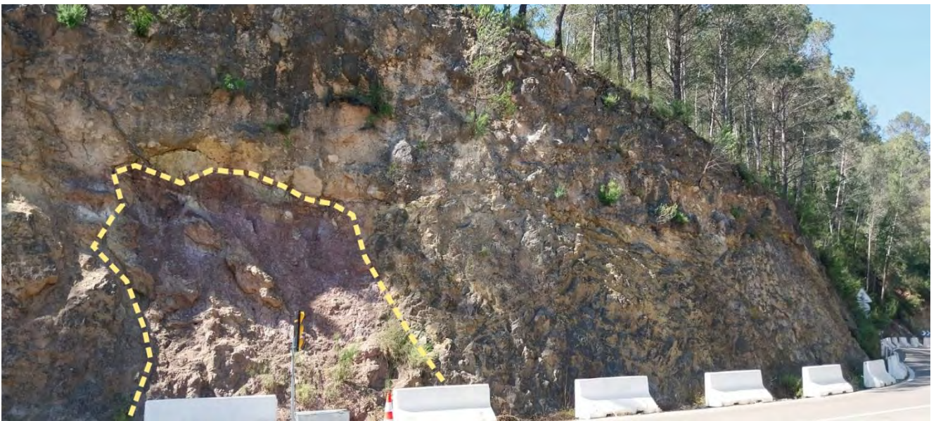
Foto 3: Vista del contacto entre materiales permeables (rocas carbonatadas de tonos marrón gris) e impermeables (arcillas de tonos rojo-granates)
