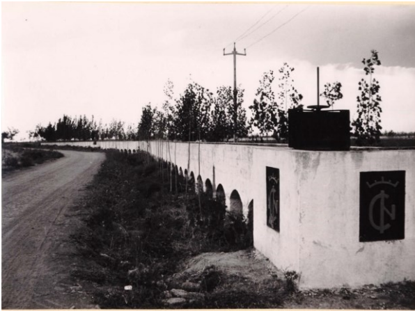
Foto 15. “Acequia de hormigón en la Zona de La Mancha. Las redes secundarias de acequias construidas “in situ” alcanzan un desarrollo de 125 Km., que dominan 4.880 Has. regables útiles”. (Fuente: Instituto Nacional de Colonización, 1964)
