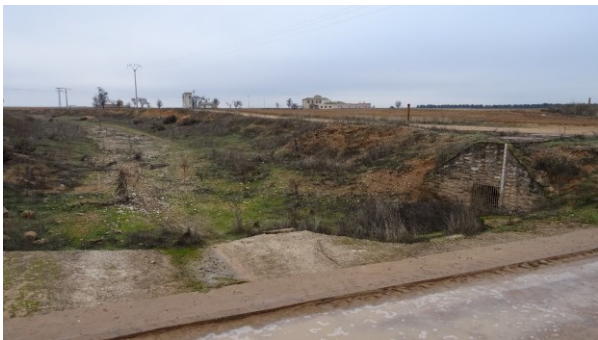
Foto 10. Uno de los sondeos de recarga del sencillo dispositivo construido a finales de la década de 1990 en Alameda de Cervera.
