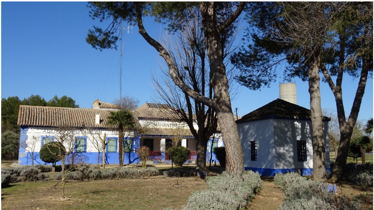
Foto 11. Casa del pozo original de Las Perdigueras. En primer término, el edificio de acceso al pozo.
