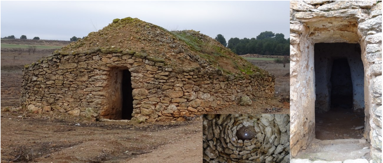
Foto 5. Bombo situado en las proximidades de Alameda de Cervera con detalles de una de sus cúpulas, de su entrada exterior y entrada a estancia interior.
