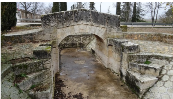
Foto 8. “Puentecillo” que cruzaba el canal del Gran Prior.
