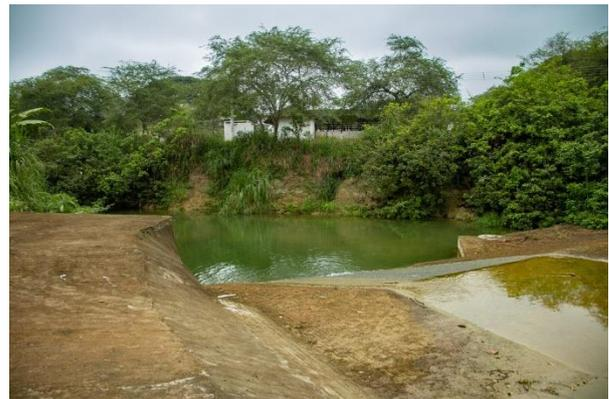
Figura VII: Dique técnico-artesanal con pendiente 4:1 en el sistema río-acuífero de Manglaralto.
