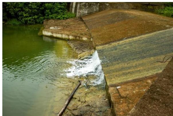
Figura IV: Tape técnico-artesanal en el sistema río-acuífero de Manglaralto, utilizado para la recarga artificial del acuífero y el suministro sostenible de agua.
