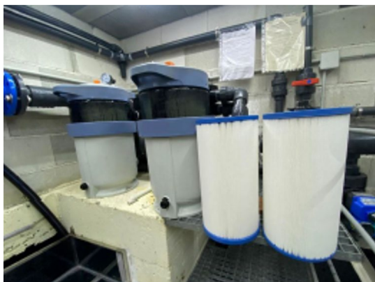
Nanofiltros para o tratamento da auga na ETAP.
