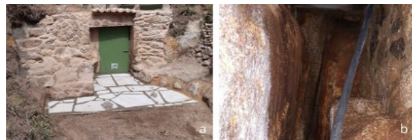
Captación dun manancial dende o exterior (esquerda) e no interior (dereita).
