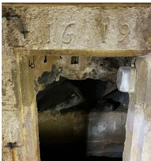
Figura 10. Mina de les fonts de Sant Roc.
