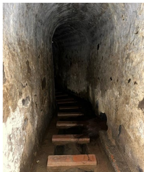
Figura 11. Galeria de conducció de l'aigua a les fonts de Sant Roc.
