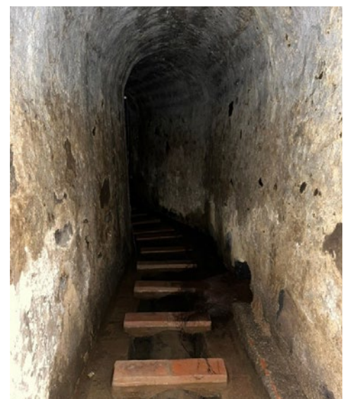
Figura 11. Galería de conducción del agua en los manantiales de Sant Roc.
