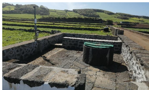
Fig 5: Poço das Courelas.
