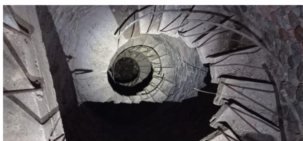
Foto 1 Escalera helicoidal de 14 m en una campana de acceso a la mina de agua "Cuesta Garrote", construida en 1955-1956 en el Barranco de Tirajana (Gran Canaria).
