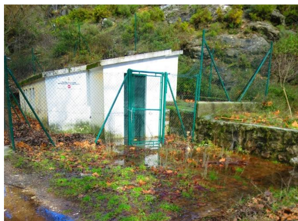
Foto 22.- Caseta del manantial Fuente Grande de Huétor Santillán en un momento de aguas altas en la que el agua salía por la puerta de la captación (12/02/26)
