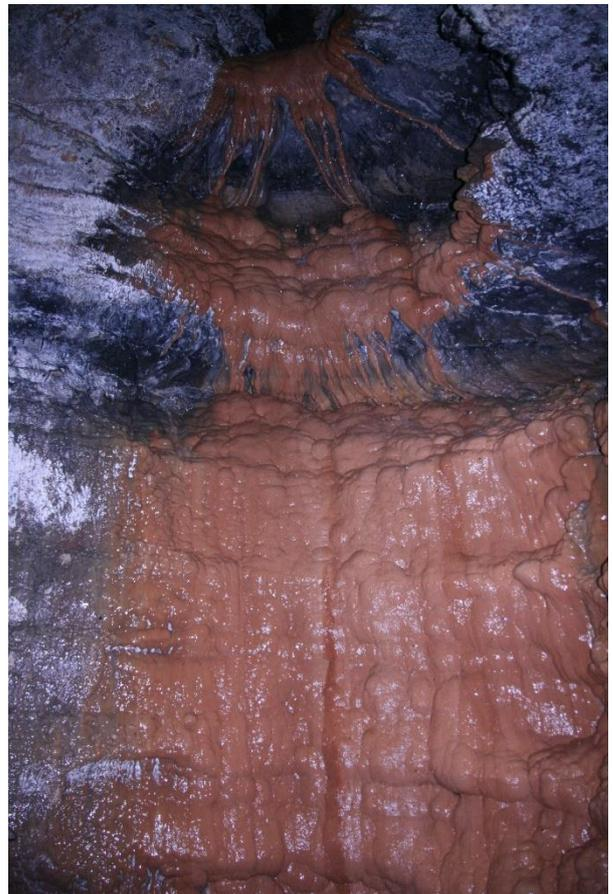
Precipitación de carbonatos en las paredes de la zona inferior.
