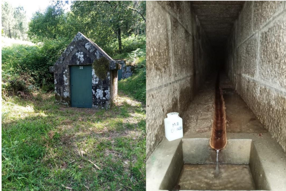
Figura 1. Minas de água subterrânea da Montanha da Penha. Na imagem à esquerda é possível observar a entrada da mina 32 e na imagem à direita podemos ver o interior de uma das minas que fornecem água cloretada-sódica de excelente qualidade para consumo humano.
