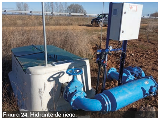
Figura 24. Hidrante de riego.
