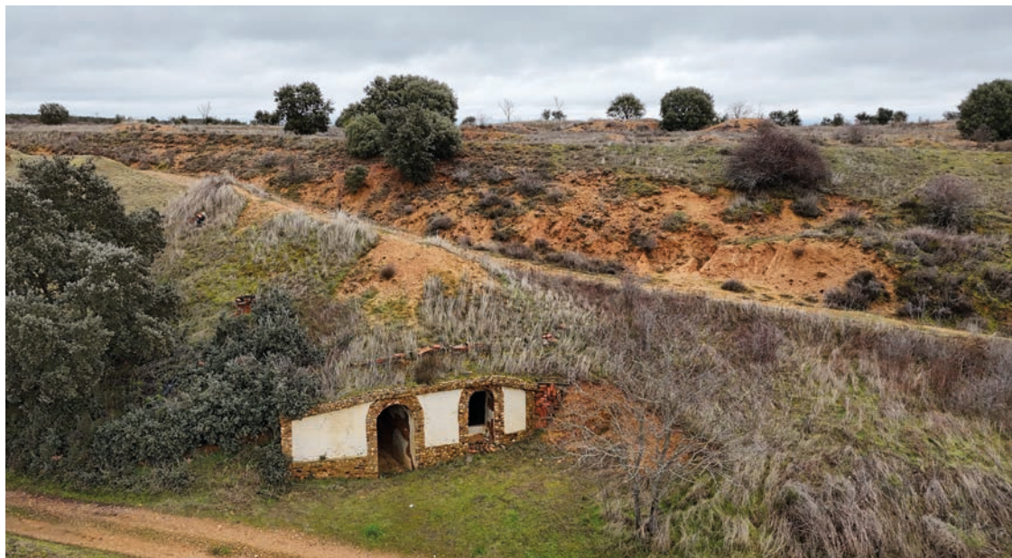
Figura 8. Típica bodega excavada en los conglomerados y arcillas que afloran junto a la localidad de Ardón.
