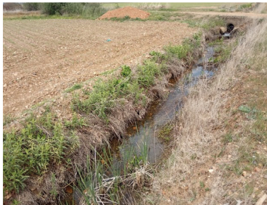
Figura 11. Acequia de tierra que capta el agua de escorrentía.
