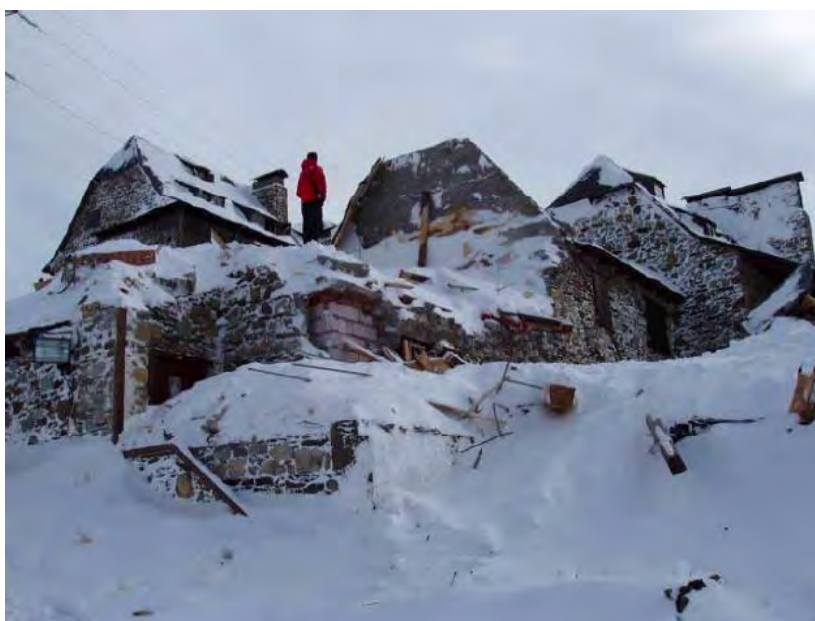
Figura 1.7. Detalle de afectación sobre los edificios de la avalancha caída el 31/01/2003 sobre la pleta de Baqueira (fotos Conselh Generau d'Aran).
