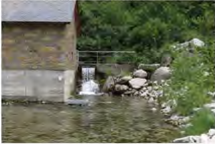
Figura 7. Captación de la surgencia de Aigüeira.
