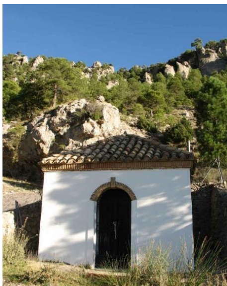
Figura 18. Edificación para la protección del manantial.
