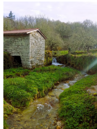
Lavadero de Forcas con flujo continuo de agua.
