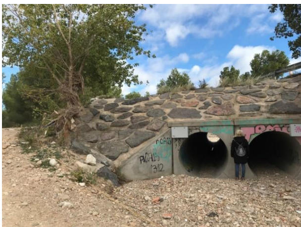
Figura 14. Conducciones para derivación del cauce del barranco de la Muerte.
