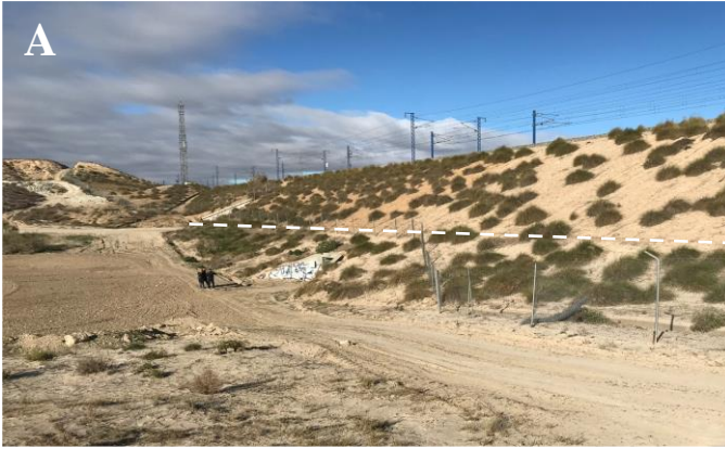
Figura 11. (A) Terraplén de la línea del AVE atravesando el barranco de la Muerte. La línea discontinua señala la altura alcanzada por el agua acumulada, que encontró salida por el paso inferior de vehículos, al fondo de la imagen; (B) Detalle en la conducción de agua (fondo del barranco).
