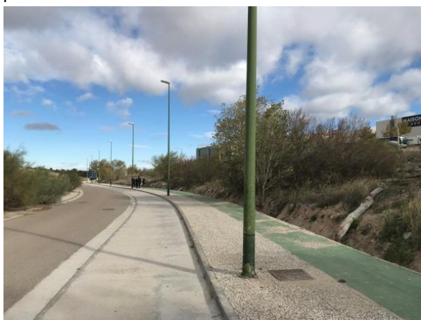
Figura 13. Tronco arrastrado por la riada y depositado elevado en una cuneta.
