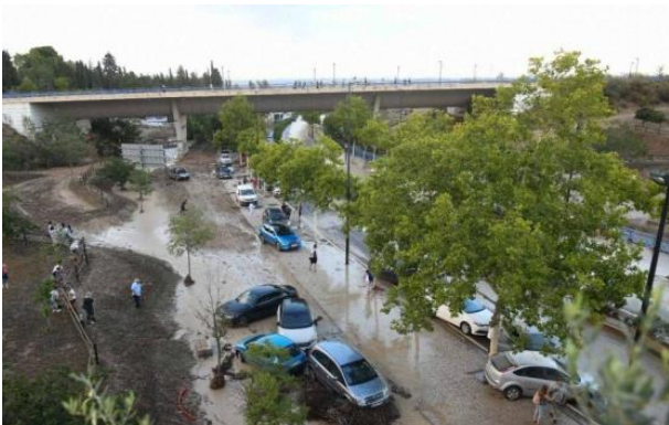
Figura 32. Efectos de la riada del 6 de julio de 2023 a su paso por el nuevo acueducto del Canal Imperial de Aragón (Fuente: Heraldo de Aragón).
