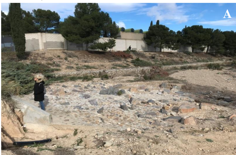
Figura 18. (A) Escolleras y diques; (B) Efectos erosivos de la riada sobre diques de contención en el Parque del Barranco.
