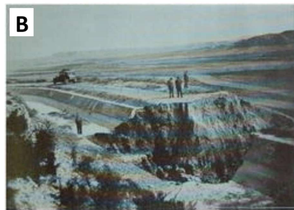
Figura 5. A) Esquema conceptual de formación de una dolina a partir de la karstificación de materiales evaporíticos en el subsuelo, cómo afecta a los materiales aluviales que se encuentran encima y formación de una dolina en superficie (Soriano y Pocoví, 2021). B) Dolina generada en 1954 afectando al canal La Violada (Gutiérrez et al., 2008).
