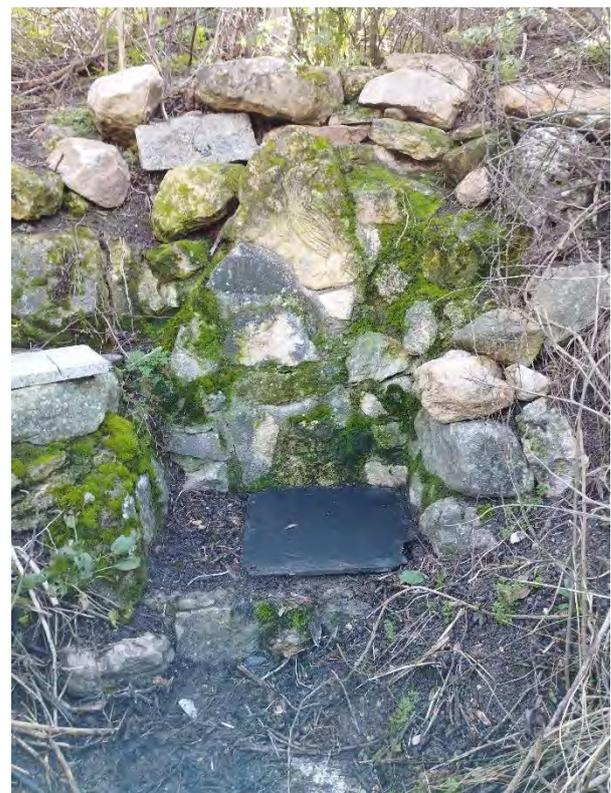
Figura 15. Aspecto actual del murete de mampostería de dolomías y calizas, y la arqueta de concentración del agua (tapada con una laja de pizarra) del manantial de la Fuente del Pájaro.
