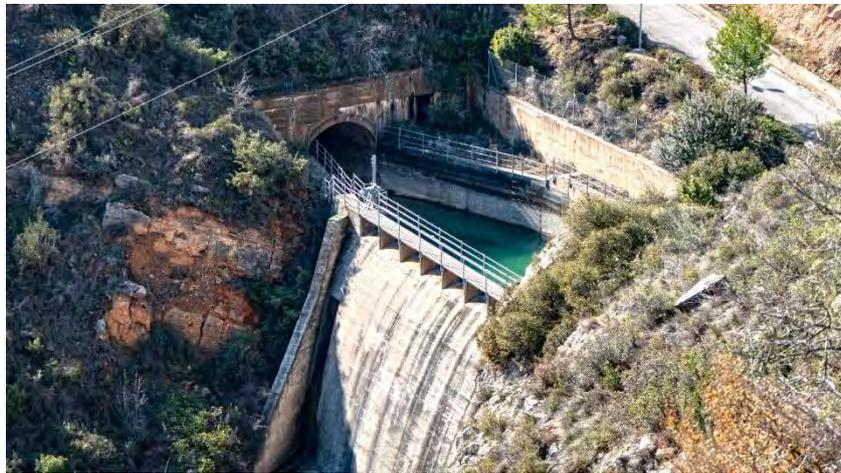
*Figura 35. Canal de descarga del aliviadero y compuerta del Canal de Enlace.*
