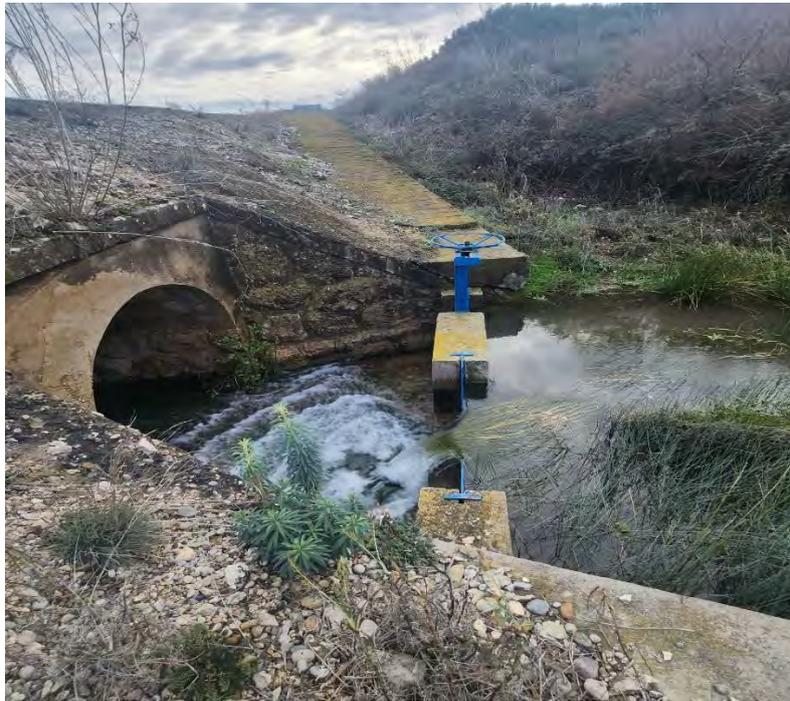
Figura 16. Vista detalle del vertedero triangular
