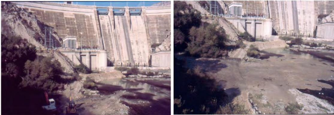
*FIGURA 27. Izquierda: Condicionamiento del lecho del río en el pie de presa para el vaciado del embalse de Santa Ana. Derecha: Apertura de las compuertas de fondo del embalse de Santa Ana (octubre de 1988) para su limpieza y reparación. Autor: Carles Balasch.*
