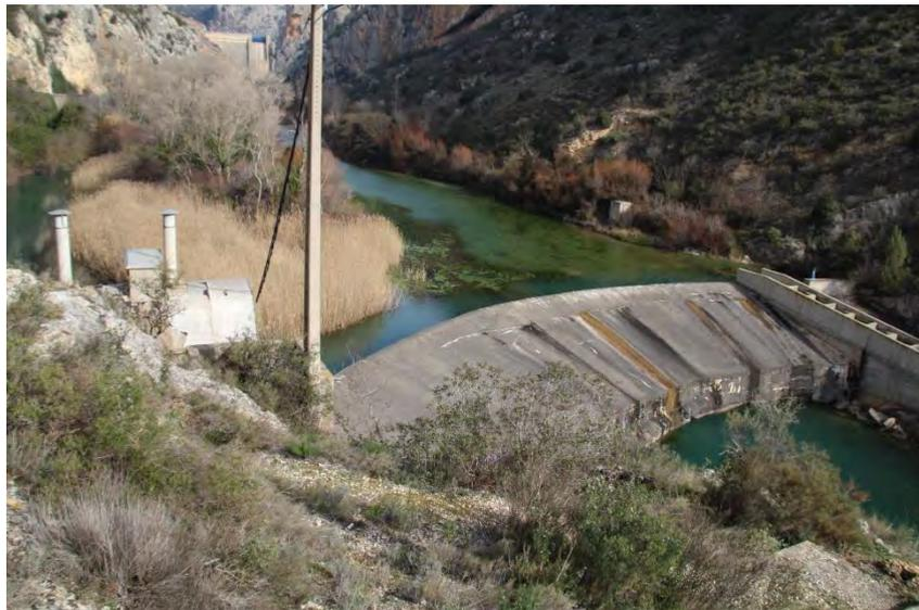
*Figura 38. Azud del Canal de Piñana, al fondo escala de peces y toma de la acequia de Ivars de Noguera.*
