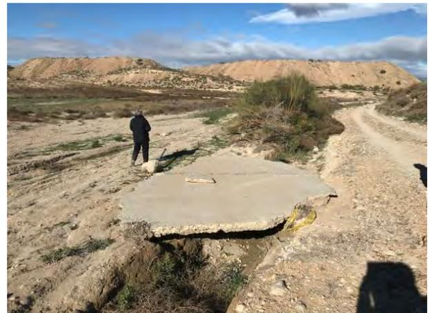
Figura 12. Losa de cemento arrancada y arrastrada por la fuerza de riada.
