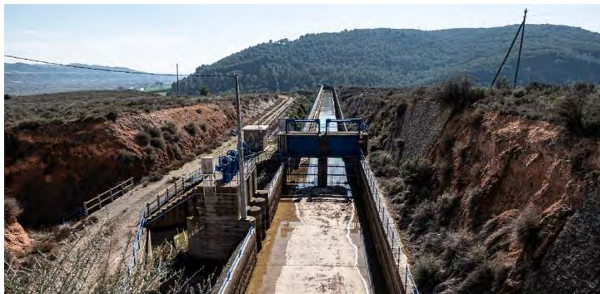
*Figura 36. Compuerta y derivación agua de boca del Canal de Enlace.*
