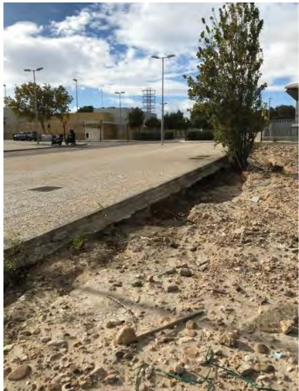
Figura 22. Descalce de plataforma y acera entre el CEIP, el supermercado y el edificio la Policía Local provocado por la erosión de la riada.
