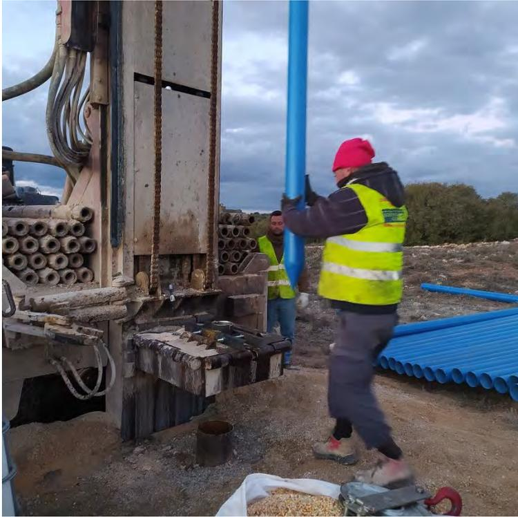
Foto 18: Entubación de un sondeo
